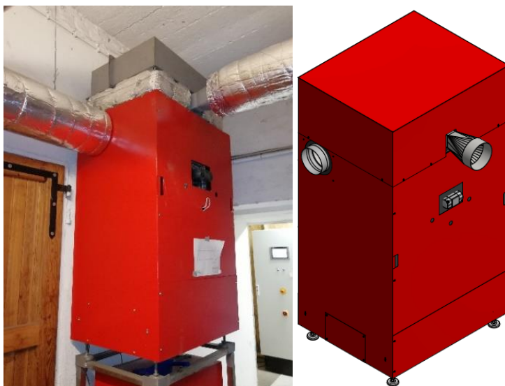
Abbildung 40: 2-Rohr-ESP im Heizraum und als 3D-Modell
