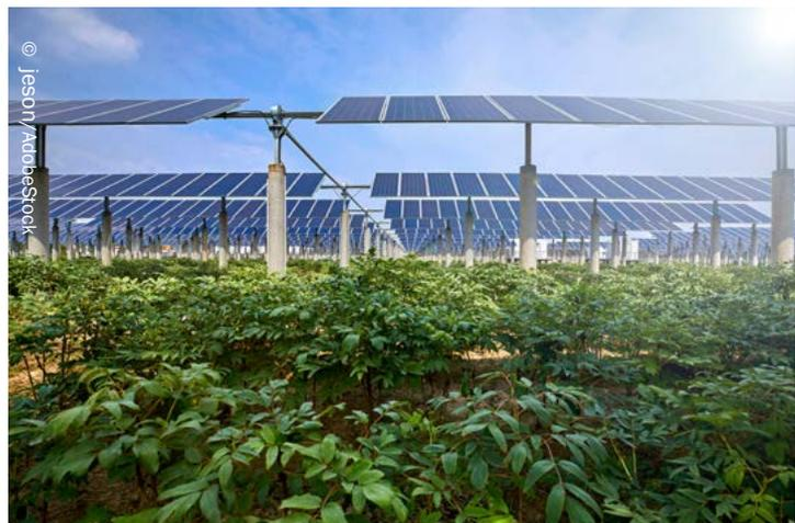
Das Agri-PV-System nutzt landwirtschaftliche Flächen für die Nahrungsmittelproduktion und erzeugt Strom mithilfe von Photovoltaikanlagen.
