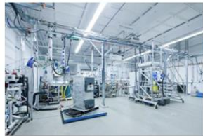
Combustion Lab 燃烧实验室
