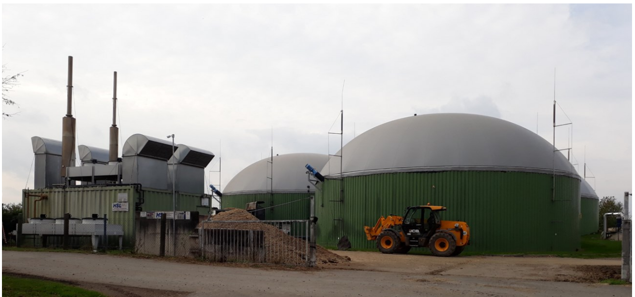
Abbildung 52: Biogasanlage der Best-Case-Anlage 1 mit Futterrestelager (vorn), beiden Fermentern und BHKW Modulen © DBFZ
