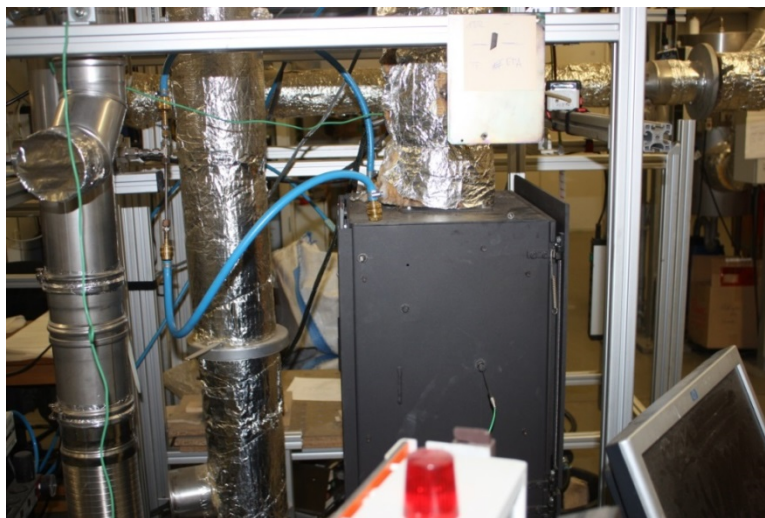
Abbildung 40: Fotografie des Versuchsaufbaus mit Luftregelung
