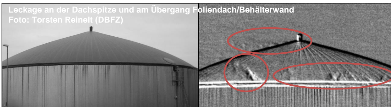
Abbildung 5-15: Gesamt Betrachtung von Leckagen an einem Nachgärer
