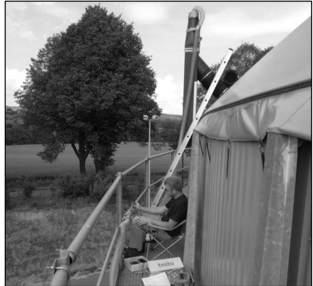
Abbildung 5-6: Messung der Methandiffusion in der Stützluft zweischaliger Biogasdächer
