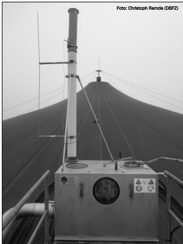
Abbildung 5-8: Rohraufsatz mit integriertem explosionsgeschütztem Flügelradanemometer, installiert an ÜUDS der Anlage A
